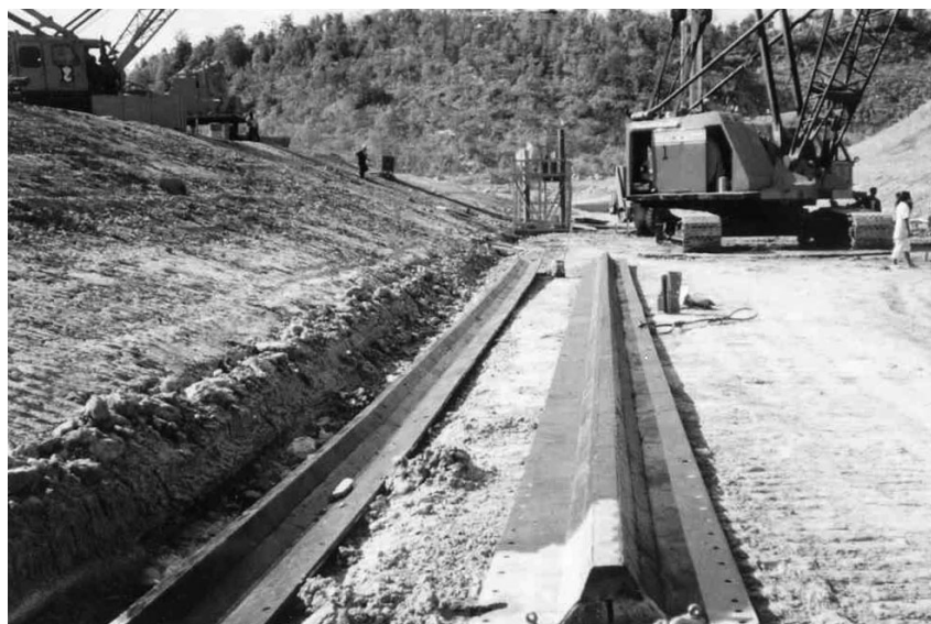
อุปกรณ์ Stoper สำหรับทำให้รอยต่อของกำแพงเป็นสลัก(Key)
