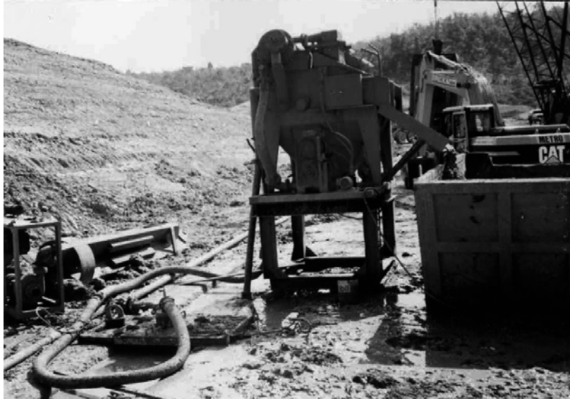
การทำความสะอาดน้ำโคลนโดยใช้เครื่องแยกทราย
