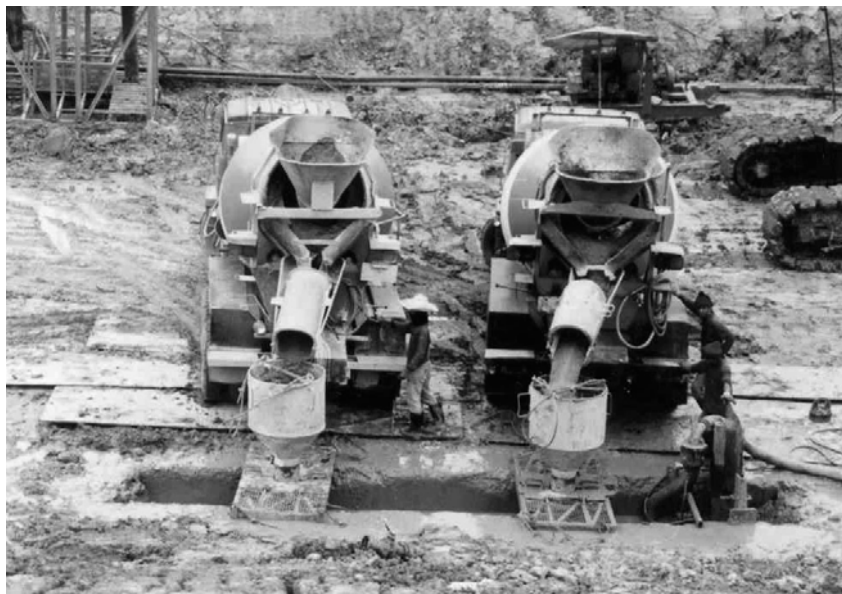
การเทวัสดุเนื้อกำแพง โดยใช้ Tremie Pipe
