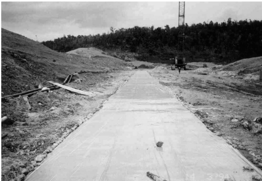
การใช้แผ่นพลาสติกปิดผิวของวัสดุเนื้อกำแพงหลังจากทำปากกระฆังแล้ว
