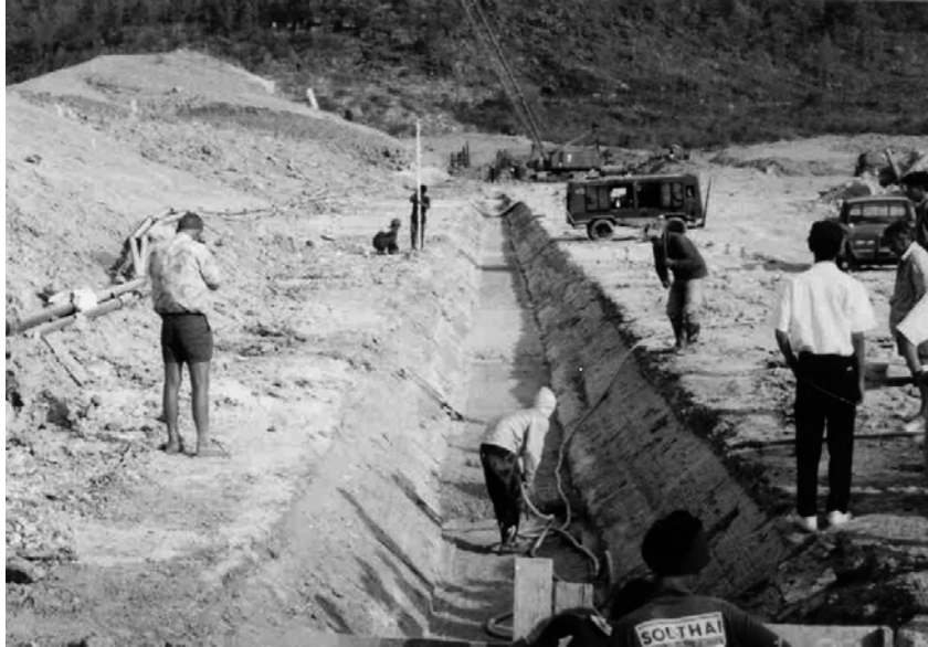
การขุดส่วนบนของกำแพงเป็นรูปปากกระฆัง
